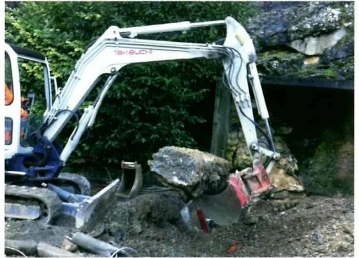
Das "alte Fundament" wird ausgebaggert
