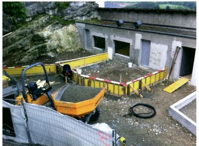
Das Fundament des neuen Geheges wird geschalt und betoniert
