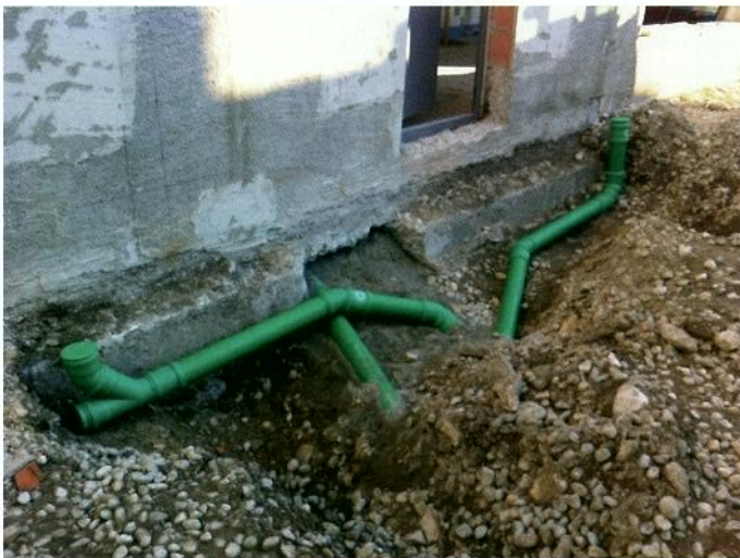
Neue Abwasserleitungen für Schmutz- und Meteorwasser werden eingelegt
